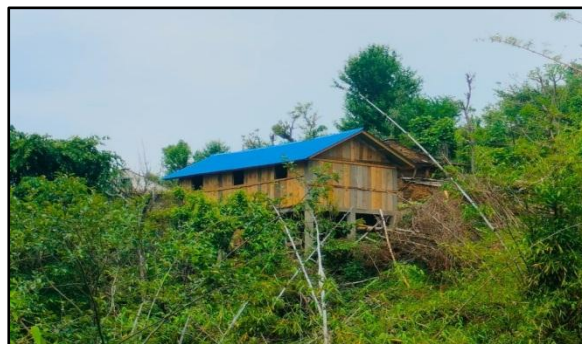
उन्नत प्रविधियुक्त बाख्रा खोर निर्माण
