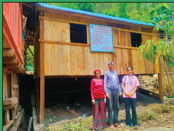
उन्नत प्रविधियुक्त बाख्रा खोर निर्माण
