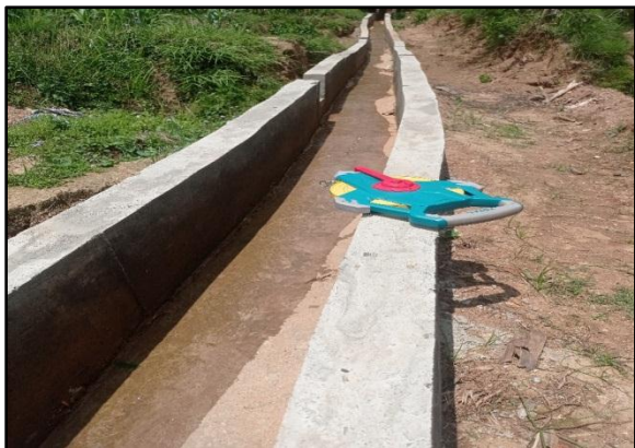
साना सिचाई निर्माण तथा मर्मत संभार कार्यक्रम अन्तर्गत सिचाई कुलो र पक्की पोखरी निर्माण
